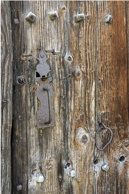
Façade ouest : détail d'une porte de grange.
