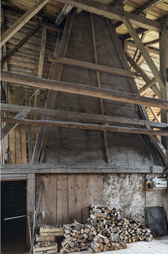
Intérieur, grange : hotte du "tué" central.
