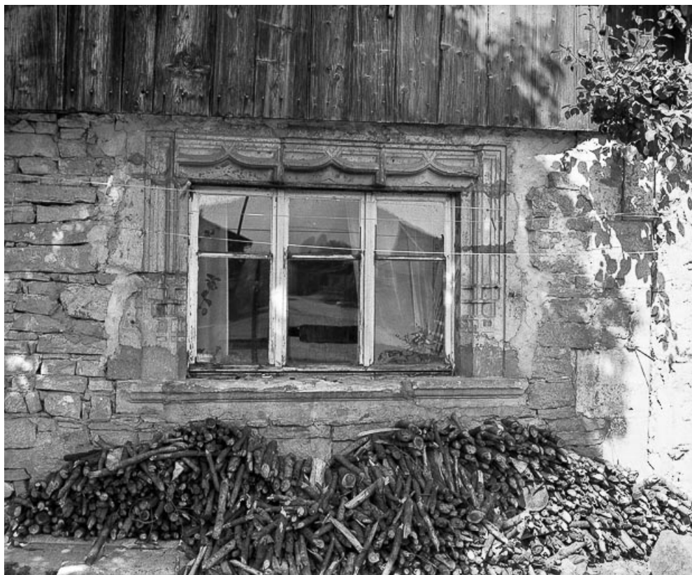
Façade antérieure : fenêtre.
