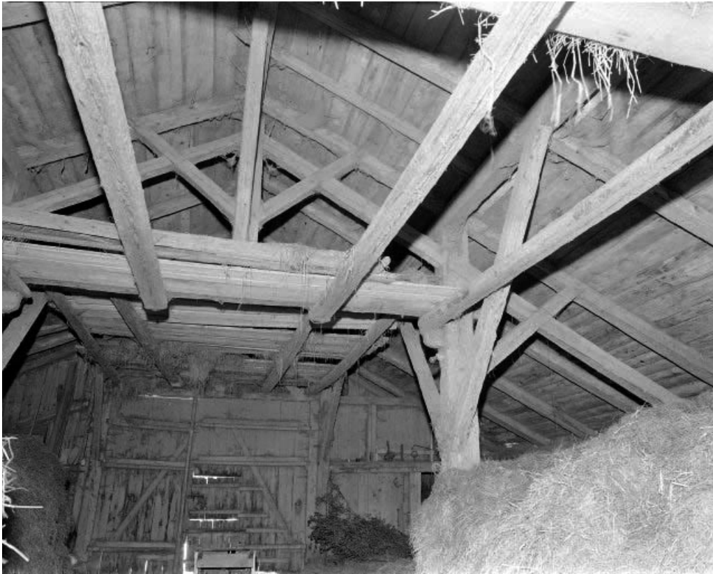
Intérieur : charpente du bâtiment annexe.
