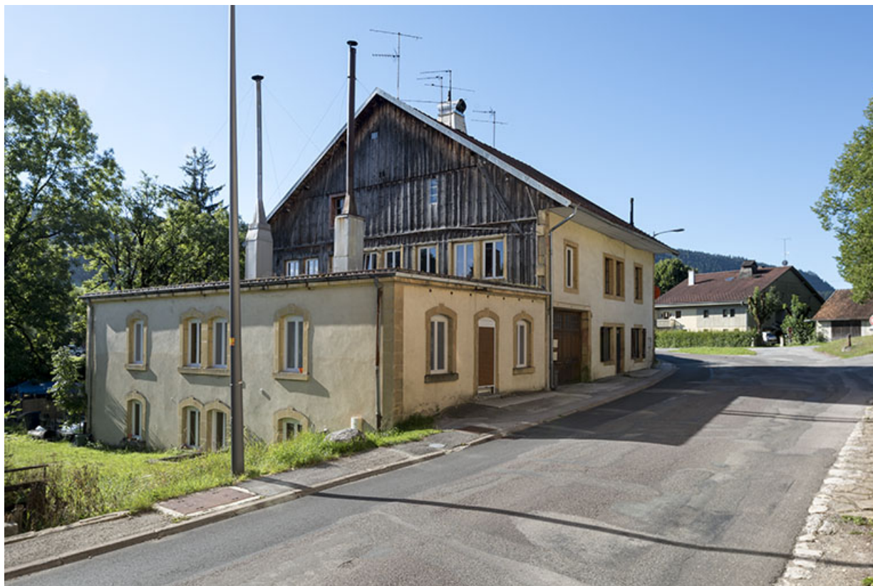
Façades antérieure et latérale gauche.
