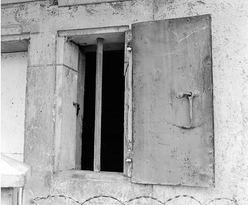
Façade antérieure : volet ouvert de la voûte.
