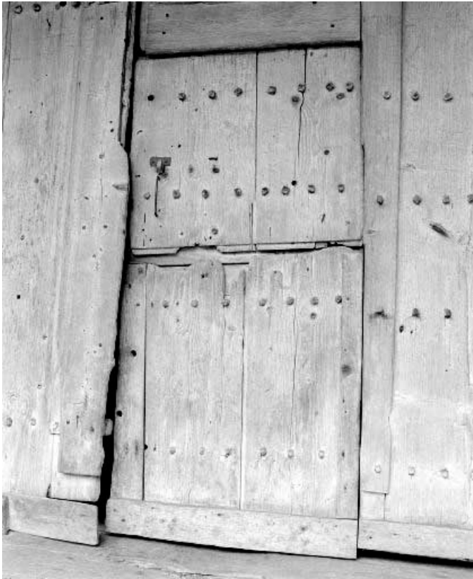
Détail : porte de grange droite, porte-guichet.
