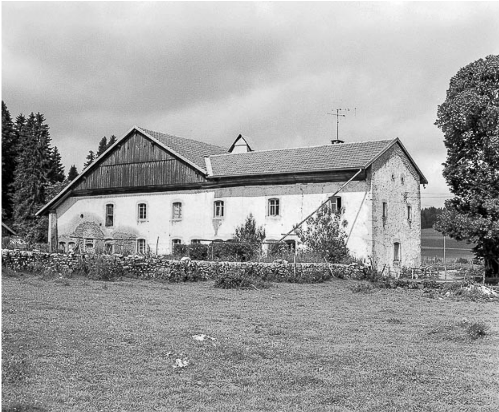
Façades antérieure et latérale droite.
