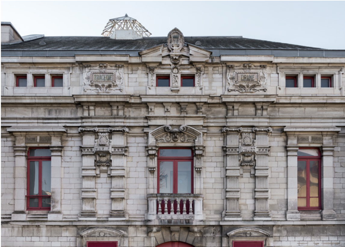
Façade latérale gauche : étage carré et attique.
