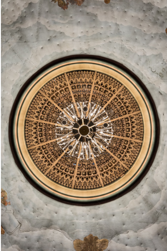
Grille métallique de l'oculus surmontant le lustre.
