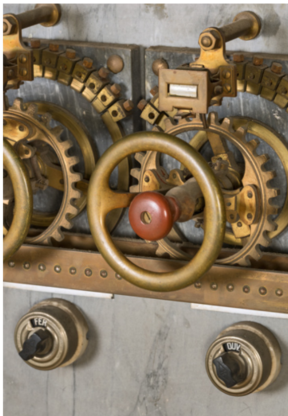
Interrupteurs et rhéostat.
