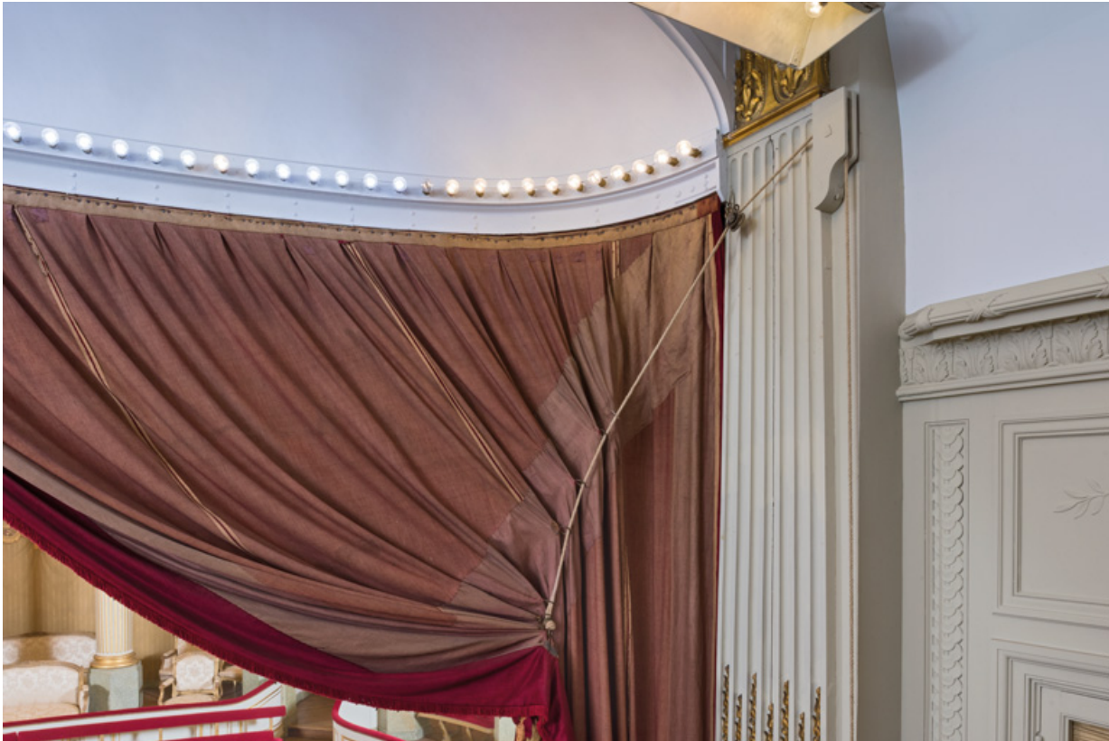
Rideau de scène : détail du système d'ouverture.
