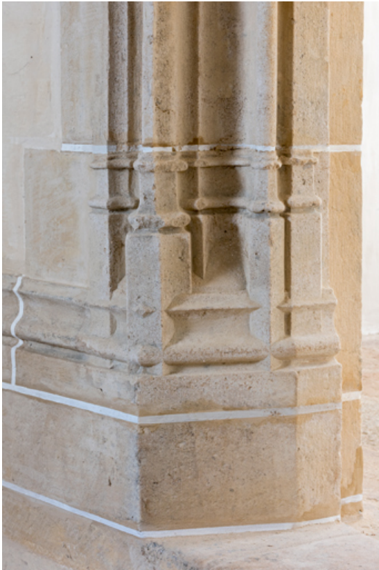
Détail : piédroit, partie inférieure.
