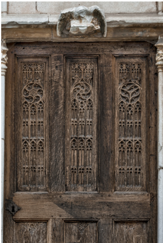
Partie supérieure, décor de fenestration.
