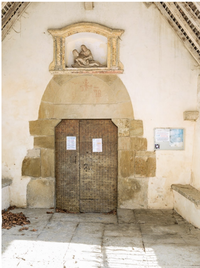
Vue d'ensemble avec la porte.
