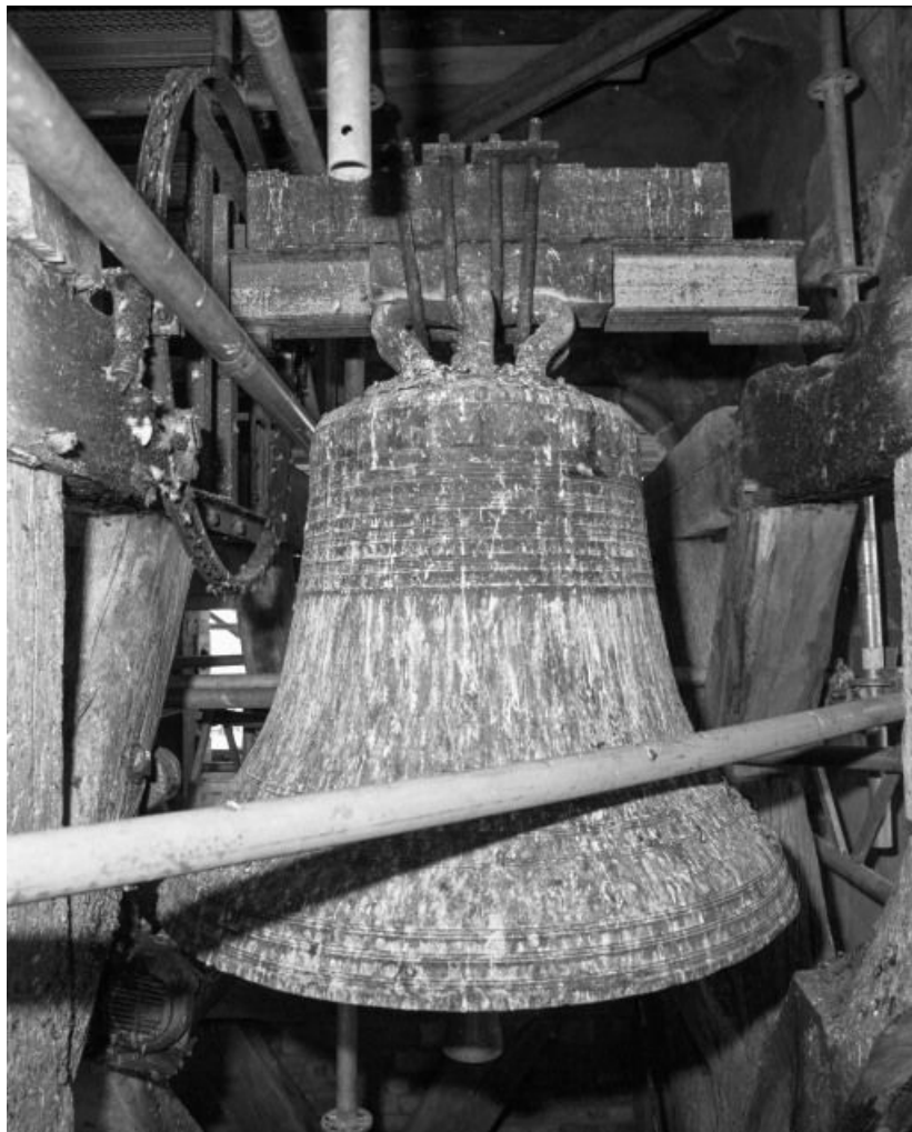
Vue pendant les travaux du clocher.
