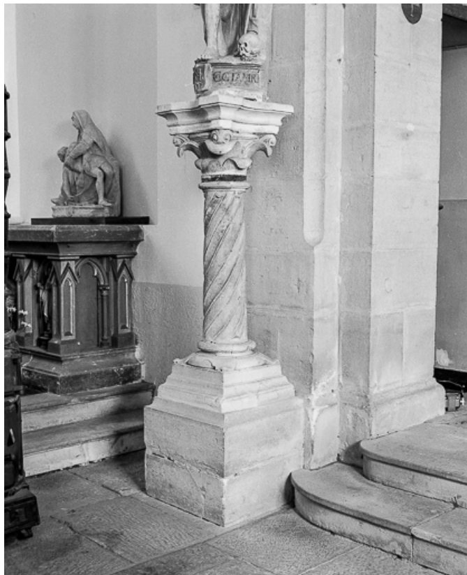
Détail de la colonne.
