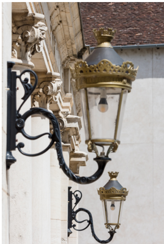
Porche : luminaires d'applique extérieurs.
