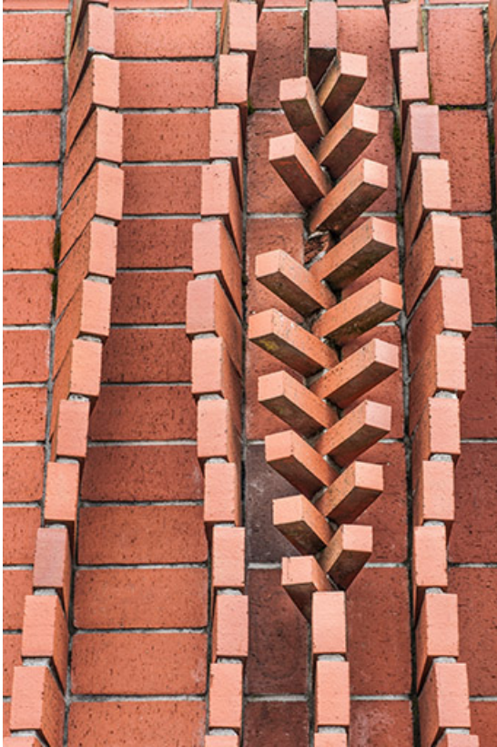
Détail du mur sud.
