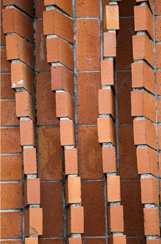
Détail du mur sud. Vue rapprochée.
