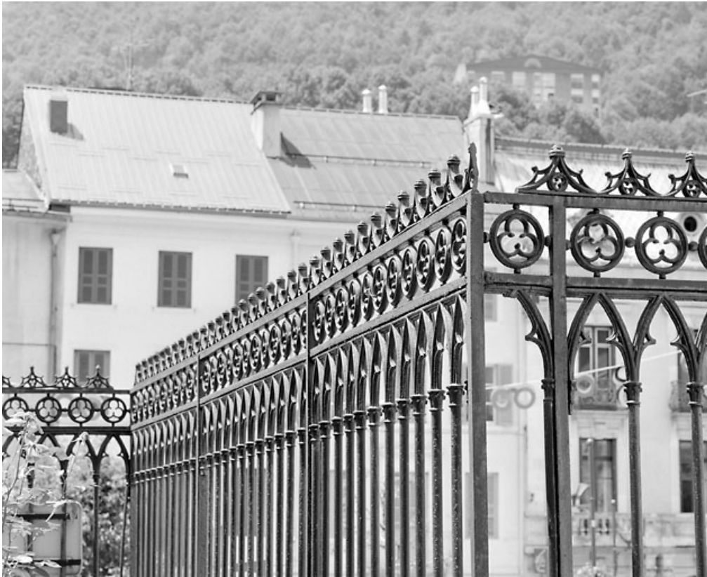
Travée fixe en retour, côté presbytère.
