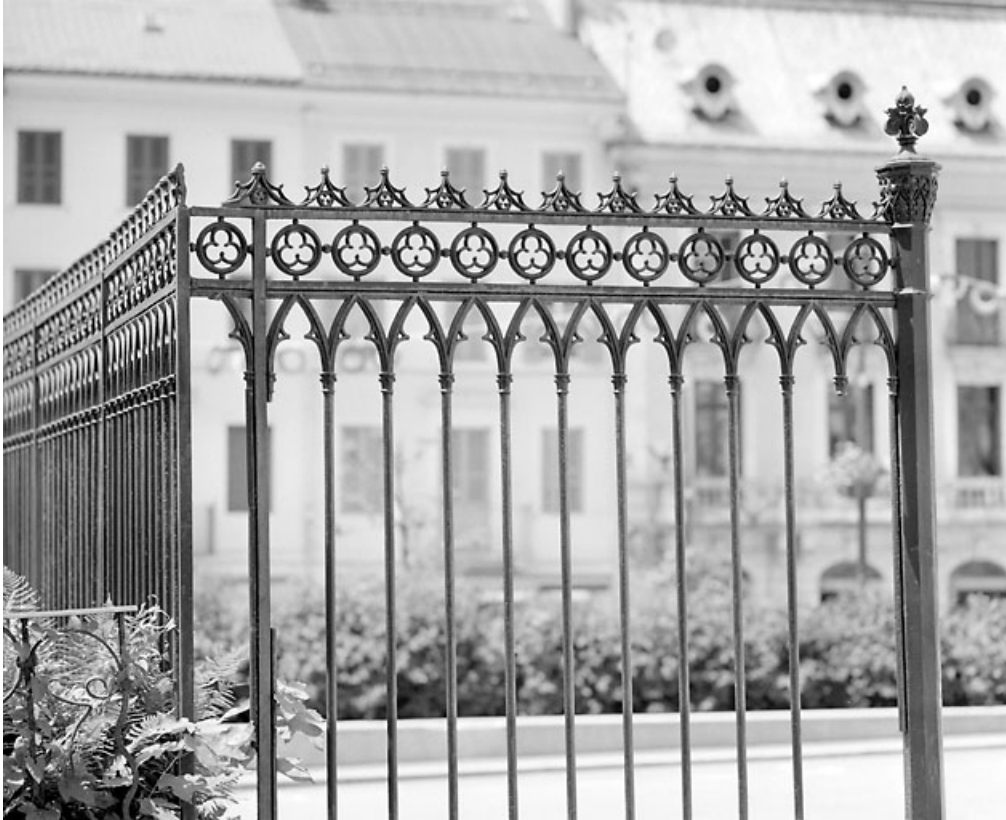
Travée fixe, côté presbytère : partie haute.
