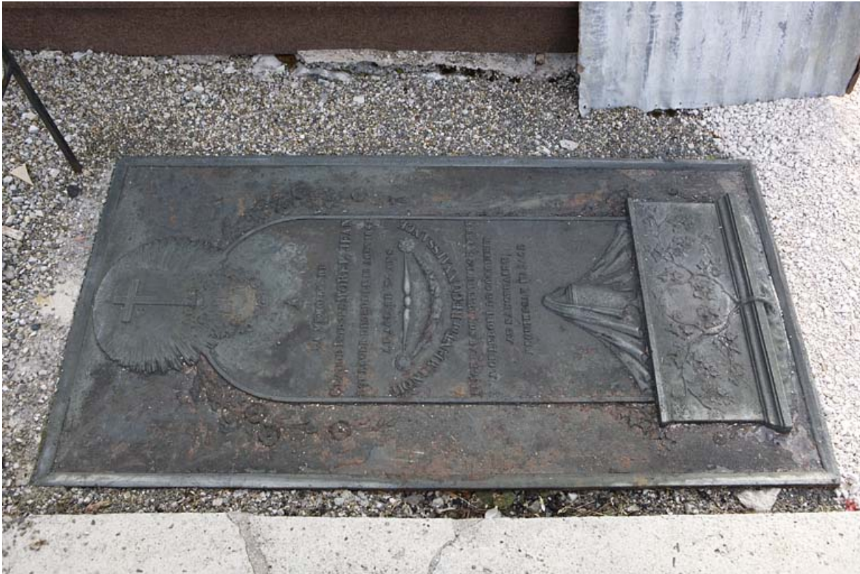
Vue d'ensemble de la dalle de fonte.
