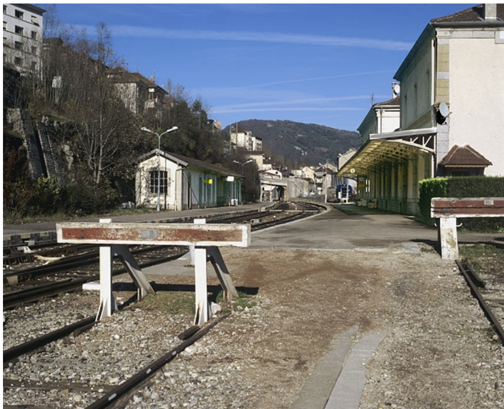
Vue d'ensemble des butoirs.
