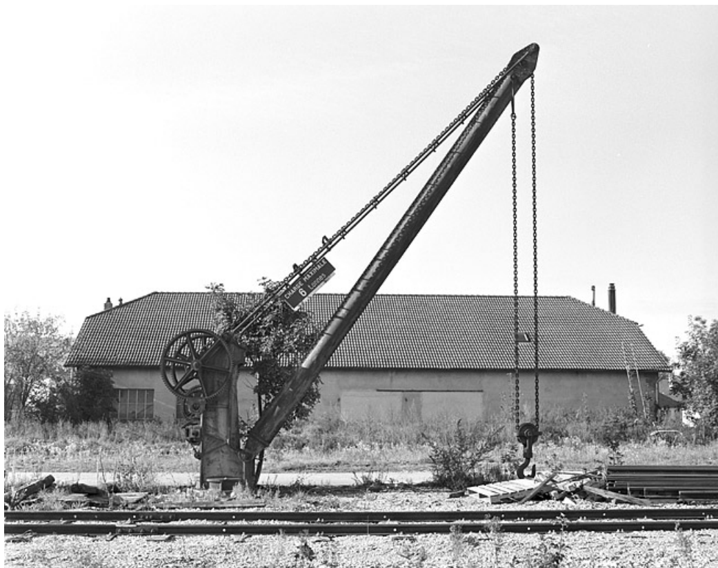
Vue d'ensemble de profil, depuis le nord-est.
