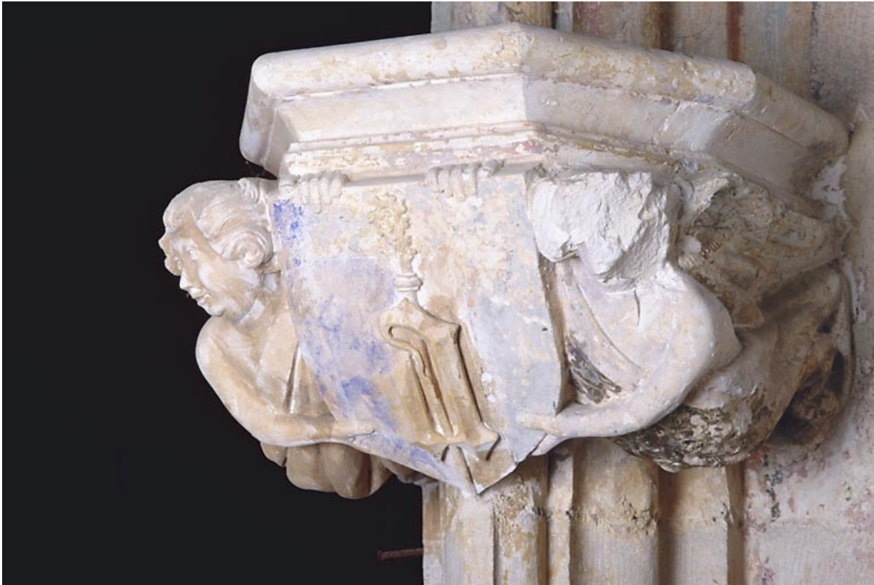
Console sud-ouest, vue de trois quarts.
