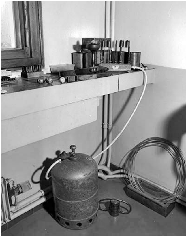
Vue d'ensemble du bec de gaz.
