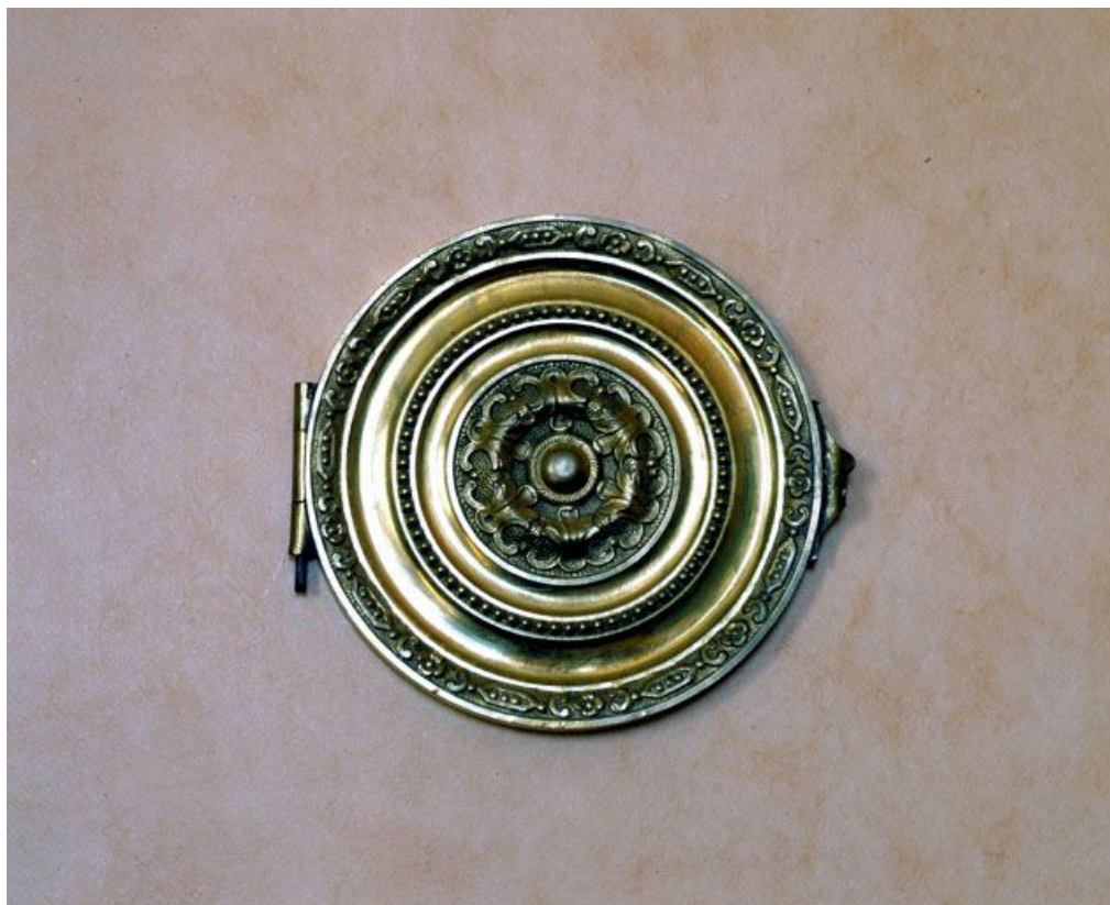
Bouche de chaleur de la cheminée, fermée.
