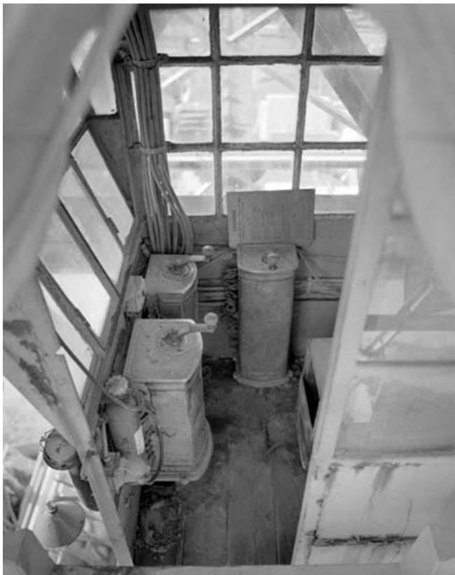
Intérieur de la cabine.
