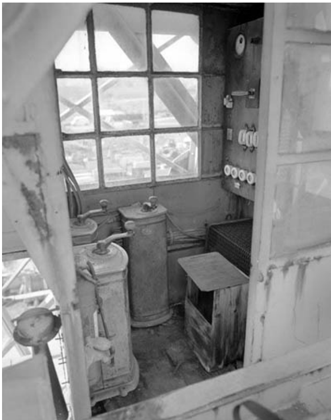
Intérieur de la cabine.
