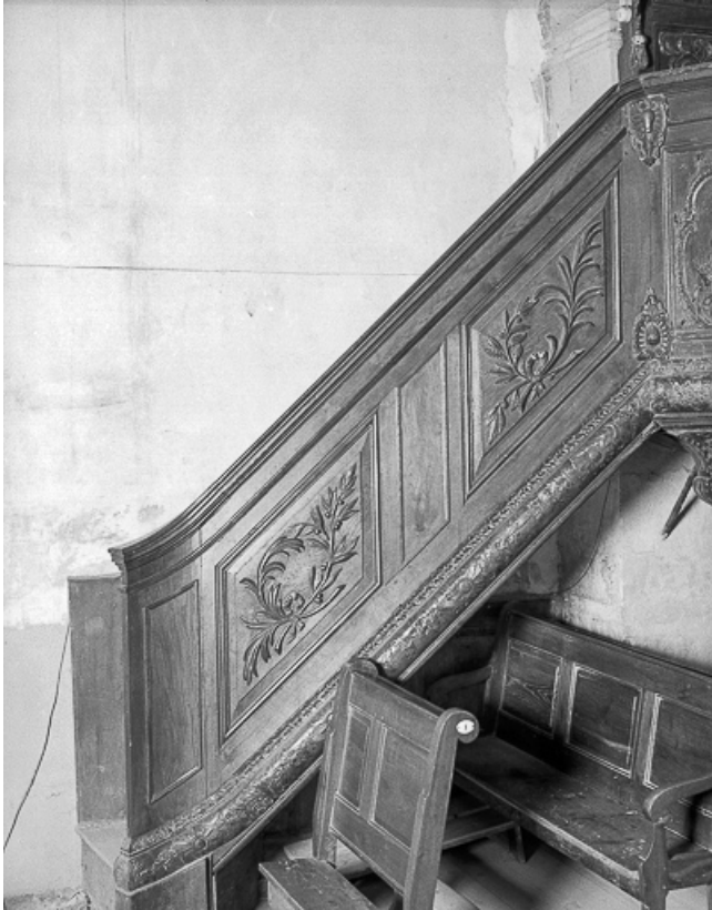
Détail : la rampe.
