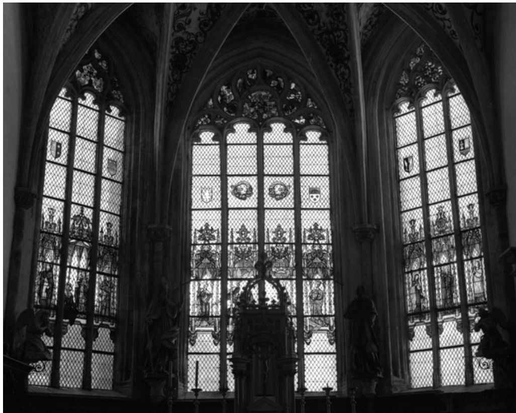
Vue d'ensemble des baies du chœur.
