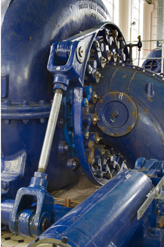
Groupe n° 1 : bras et cercle de vannage de la turbine, permettant d'en régler le débit. 25, Charquemont, lieudit : Mortier
