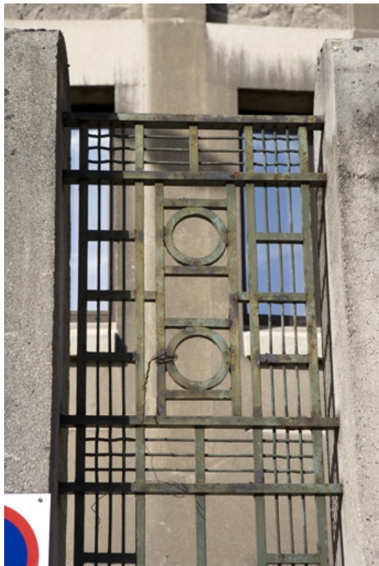
Clôture : détail d'un motif composé.
