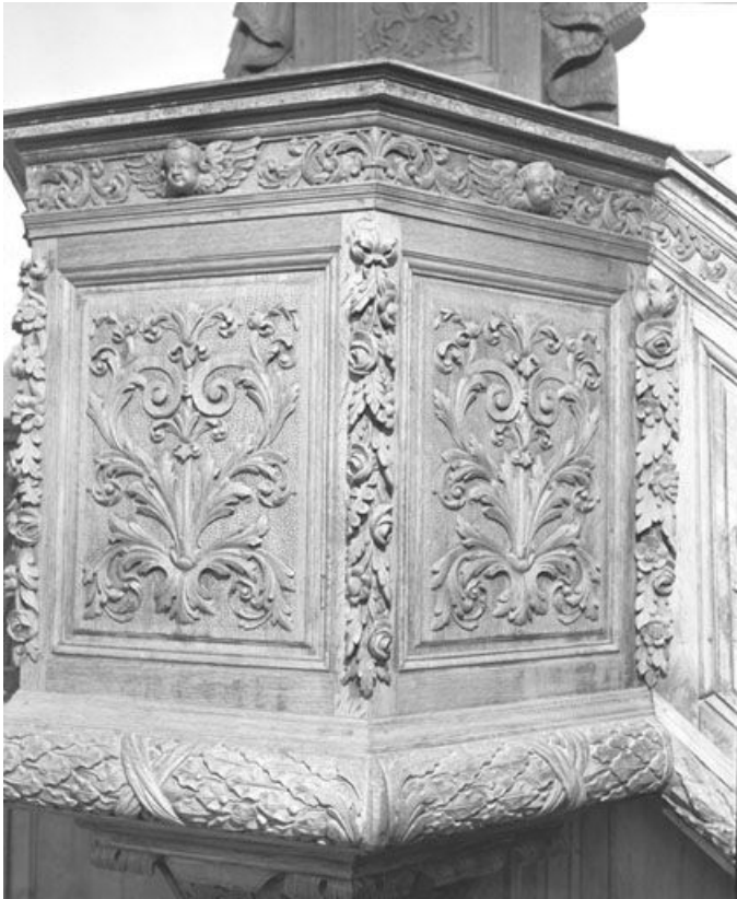
Panneaux de la cuve.
