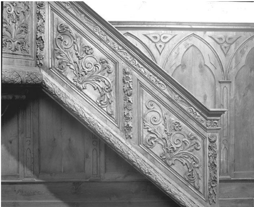
Panneaux de la rampe.
