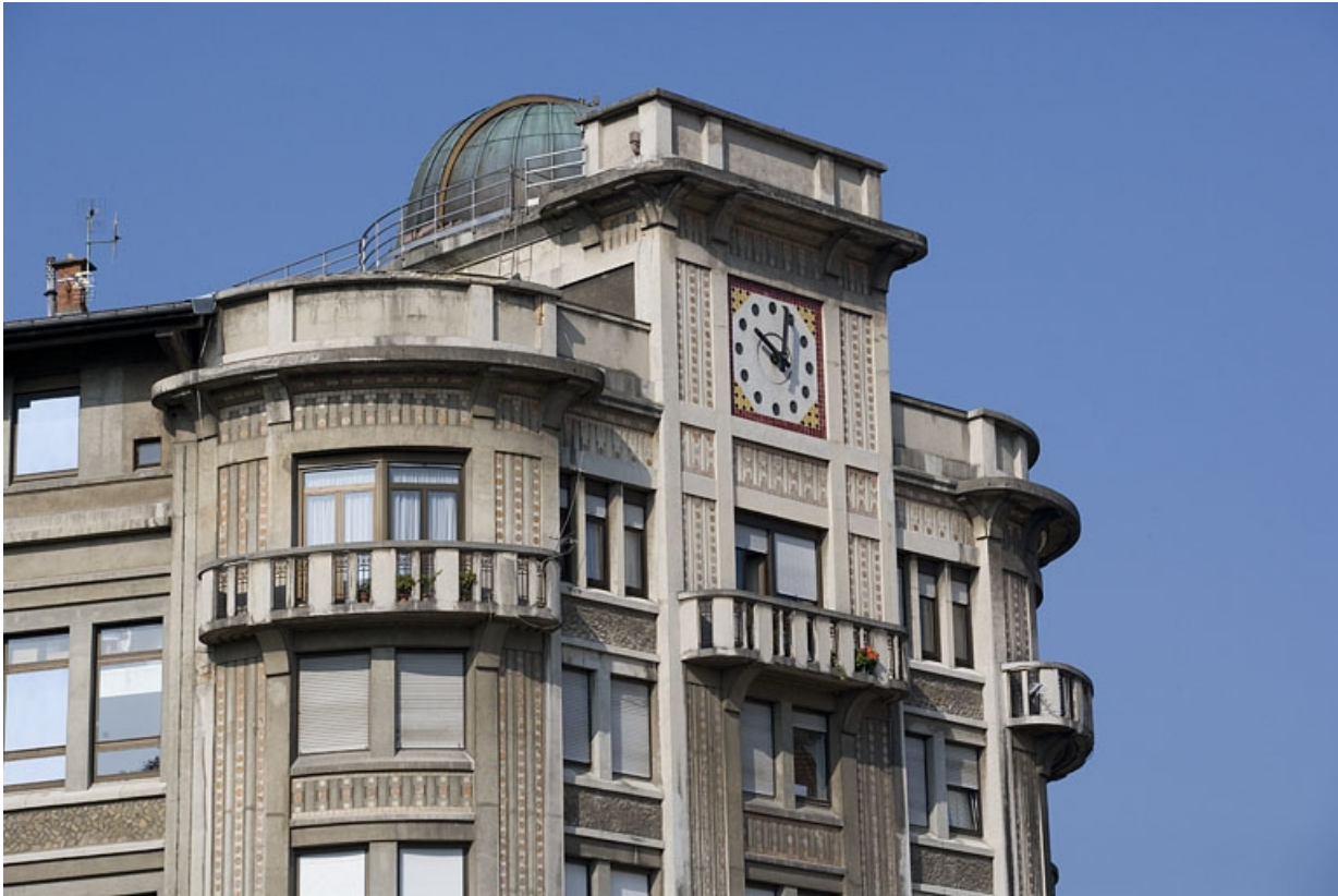
Partie supérieure du corps d'entrée et horloge.
