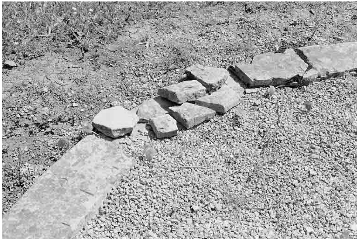
L'ellipse en pierre, avant restauration.
