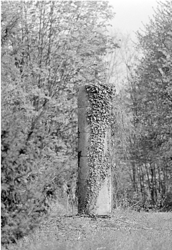
Pilier nord de la mire nord.
