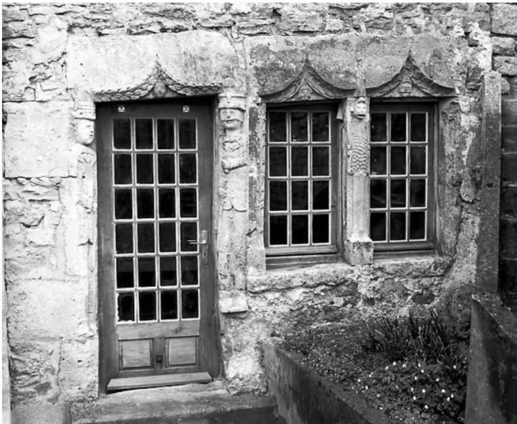
Vue d'ensemble des baies du côté cour.
