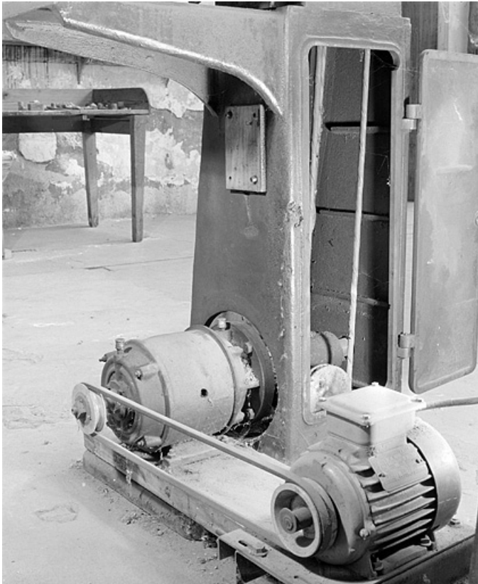
Vue des deux moteurs couplés.
