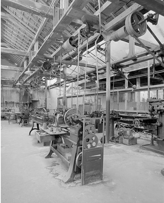
Atelier de mécanique. Distribution par courroies verticales.
