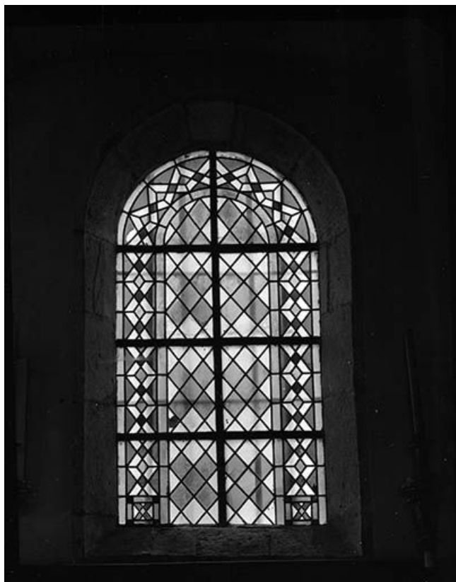
Vue générale de la baie n° 3.
