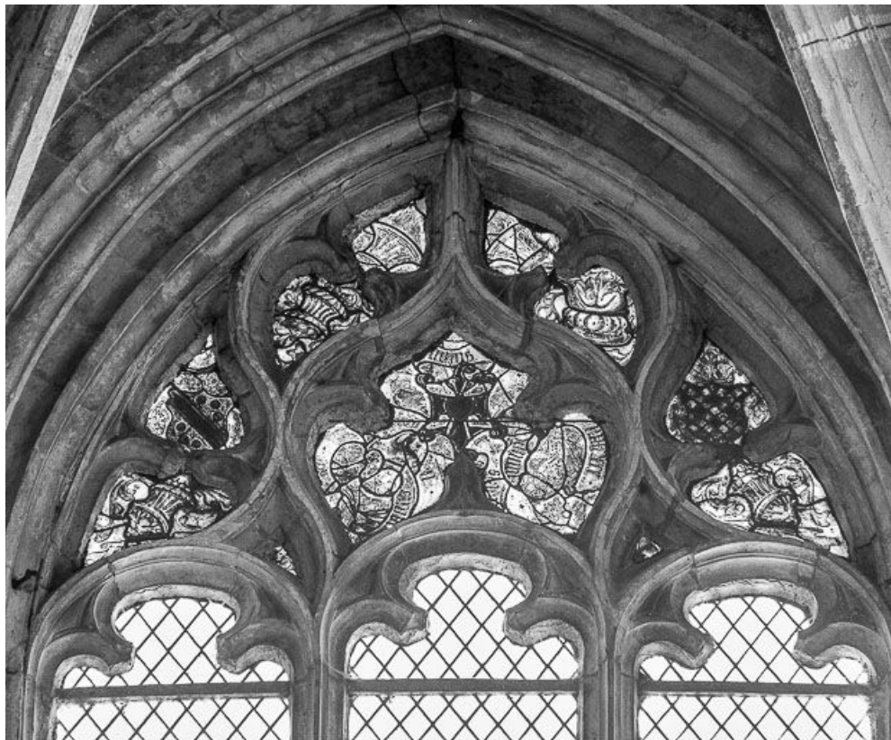
Tympan d'une des baies latérale.
