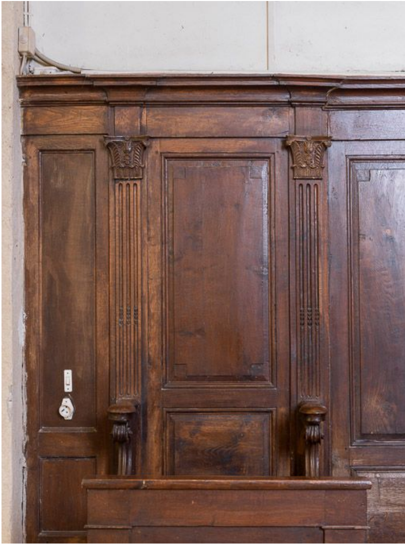
Détail des pilastres.
