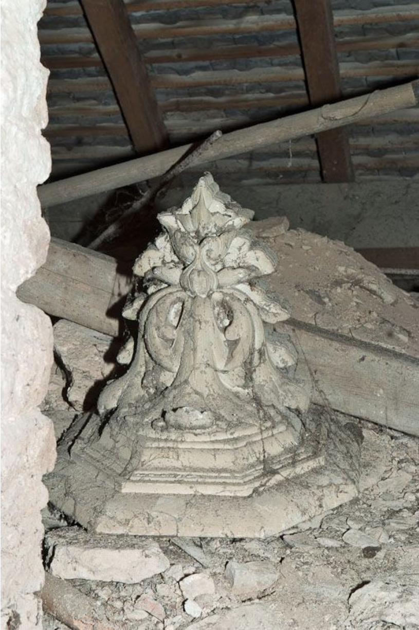
Vue d'ensemble d'une console.
