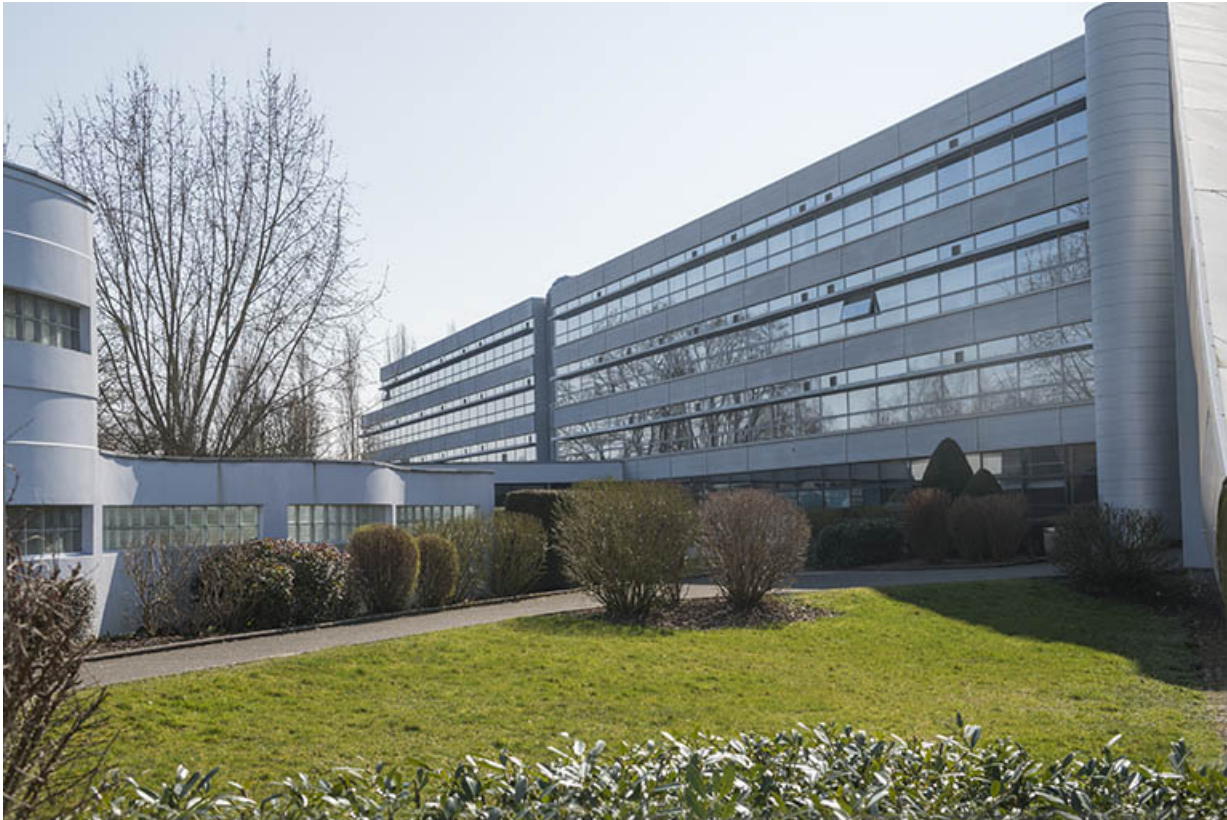
Façade est de l'aile est de l'externat.
