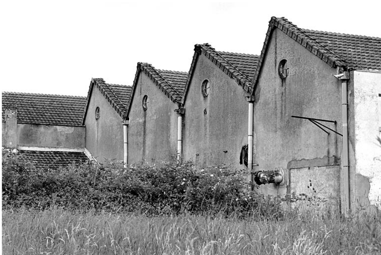
Détail de murs-pignons des sheds.
