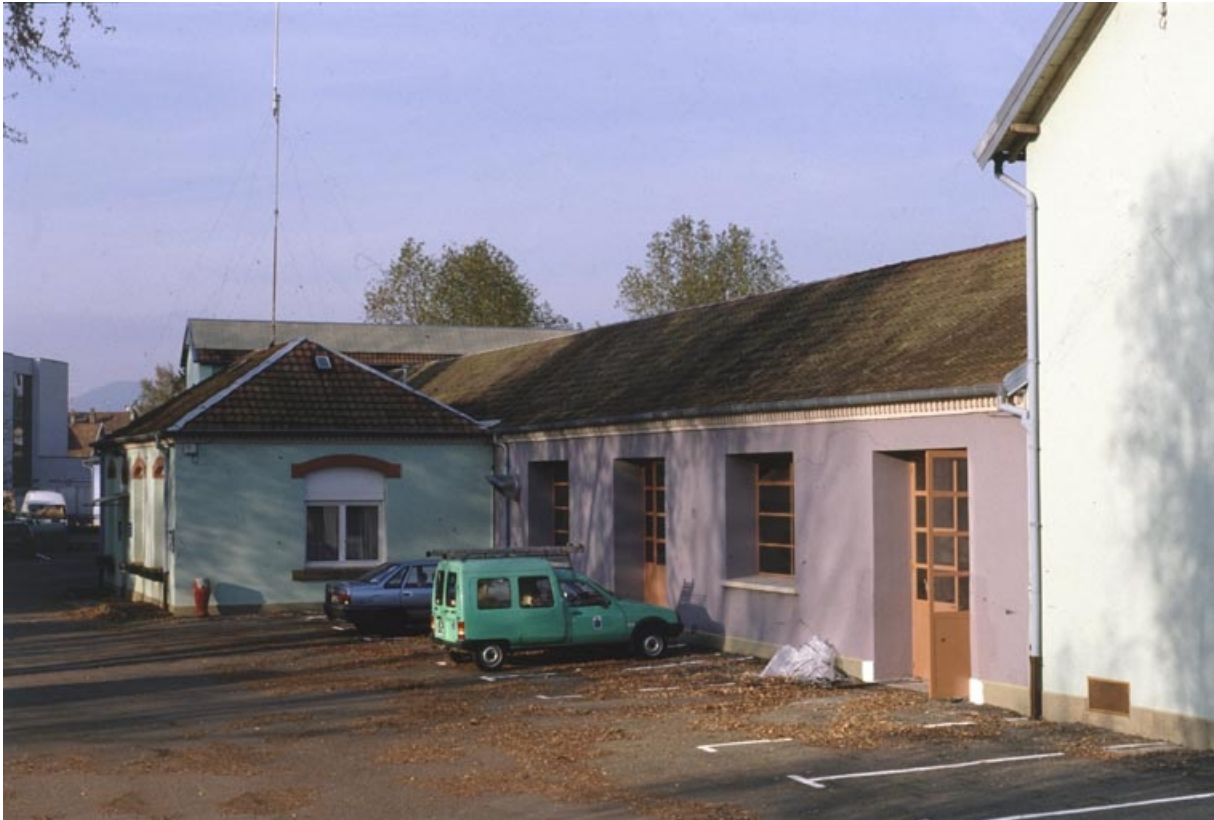
Bureaux et façade de l'atelier du tissage.
