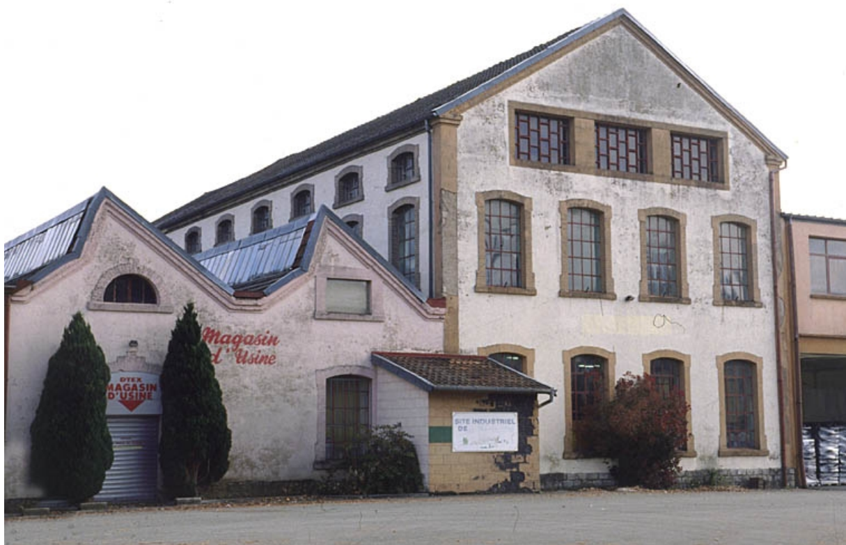
Pignons des façades antérieures.
