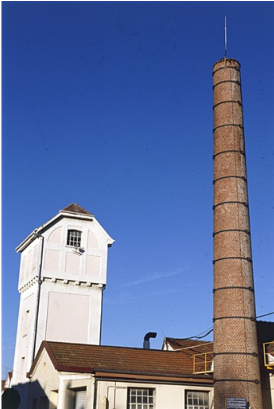
Réservoir industriel et cheminée depuis le sud-ouest.
