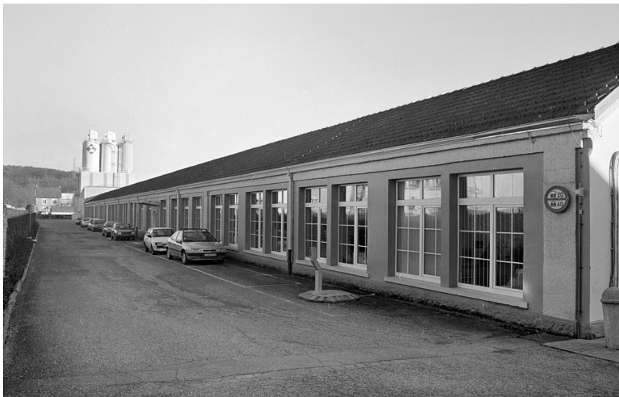
Façade nord de l'atelier de fabrication.
