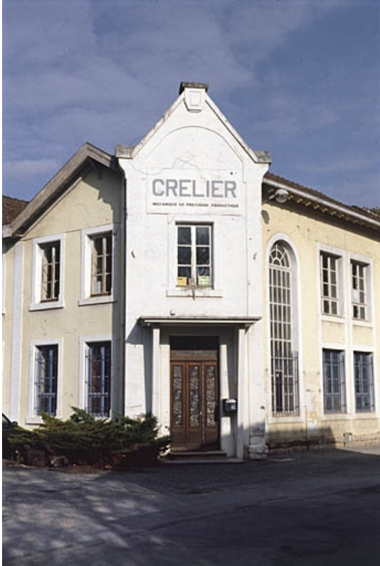
Bâtiment d'entrée : bureaux.
