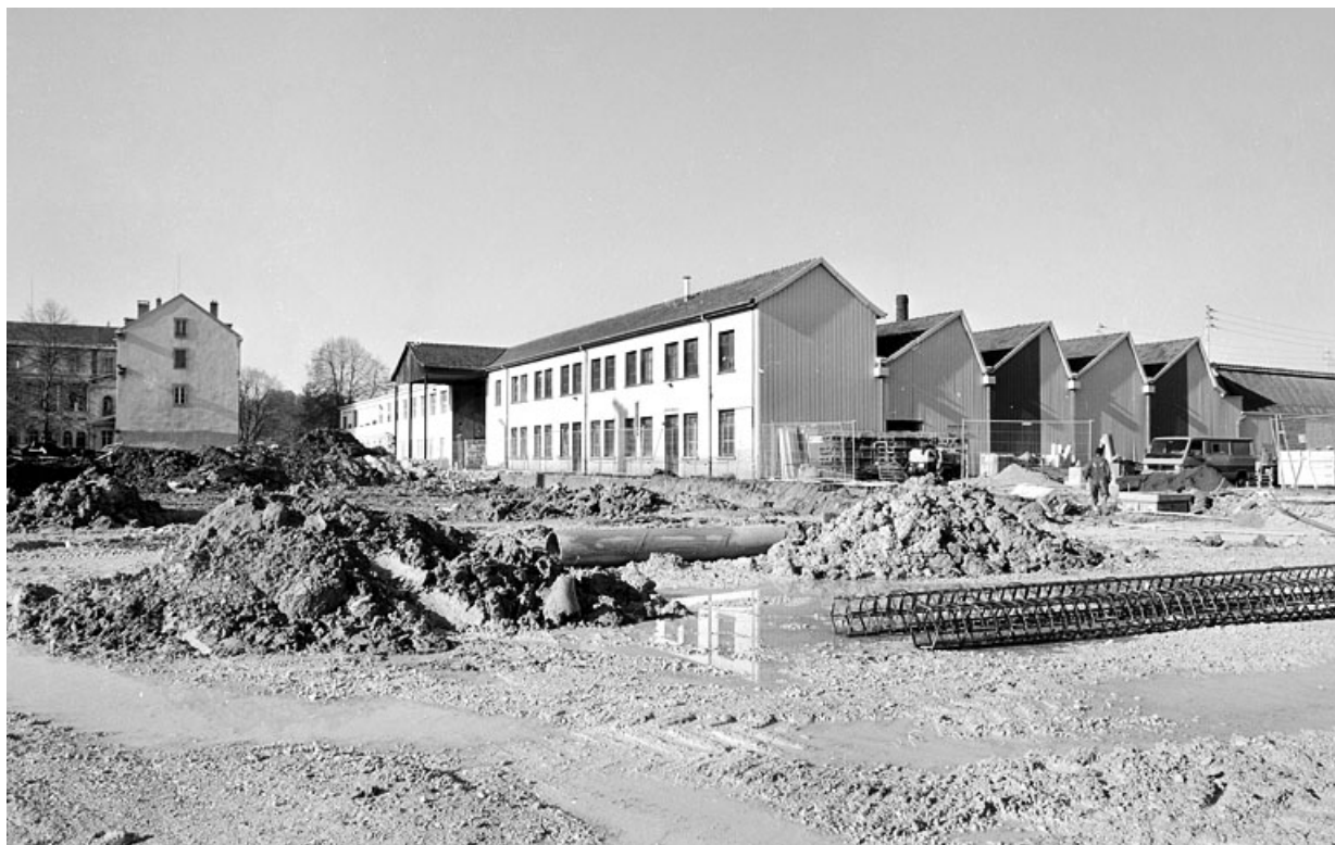
Façades postérieures des ateliers de fabrication.
