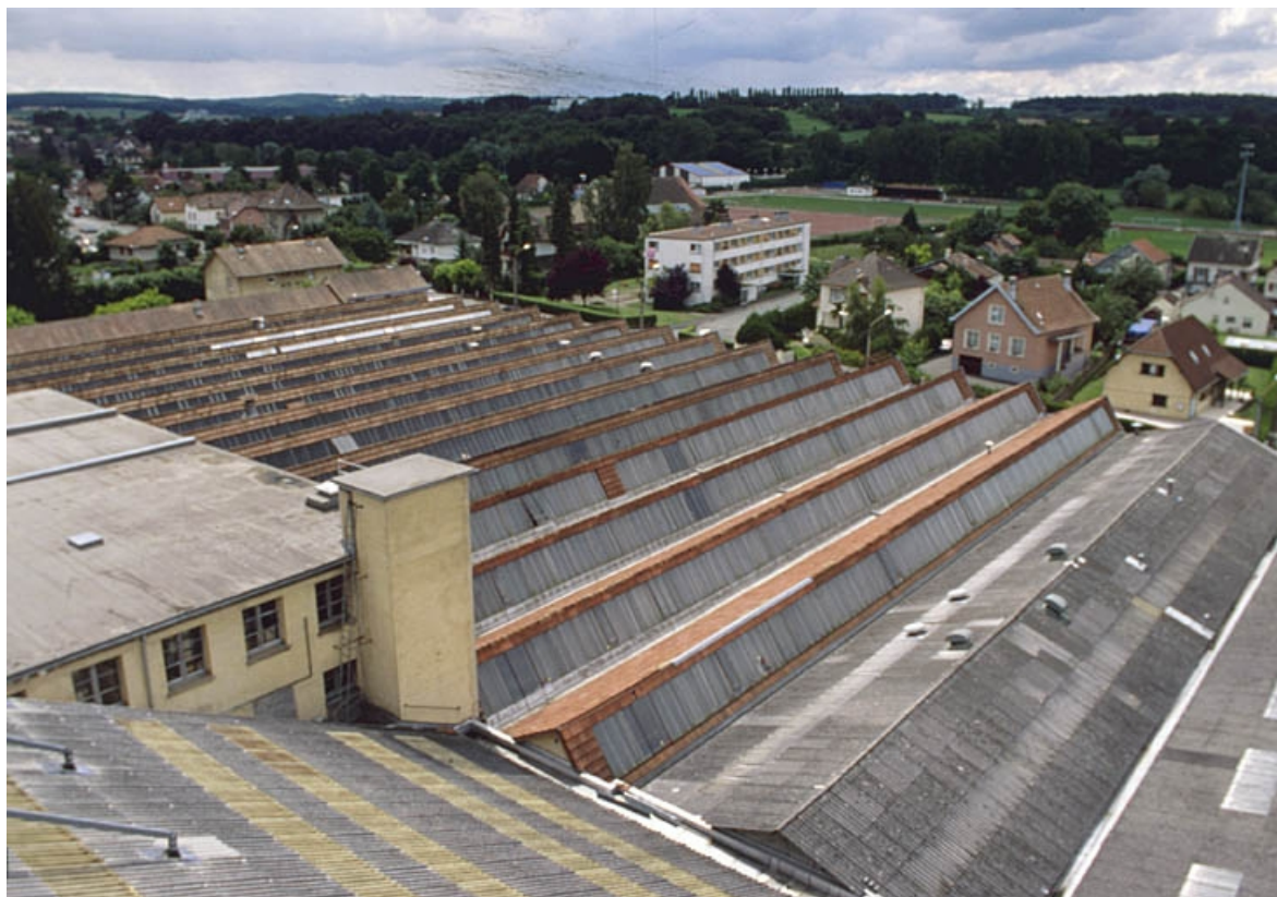
Toitures des ateliers de fabrication en rez-de-chaussée.
