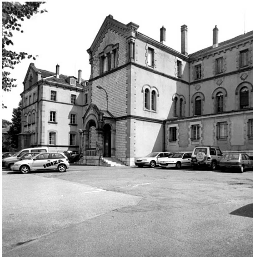
Façade antérieure de l'ancien couvent (actuellement bureaux).
