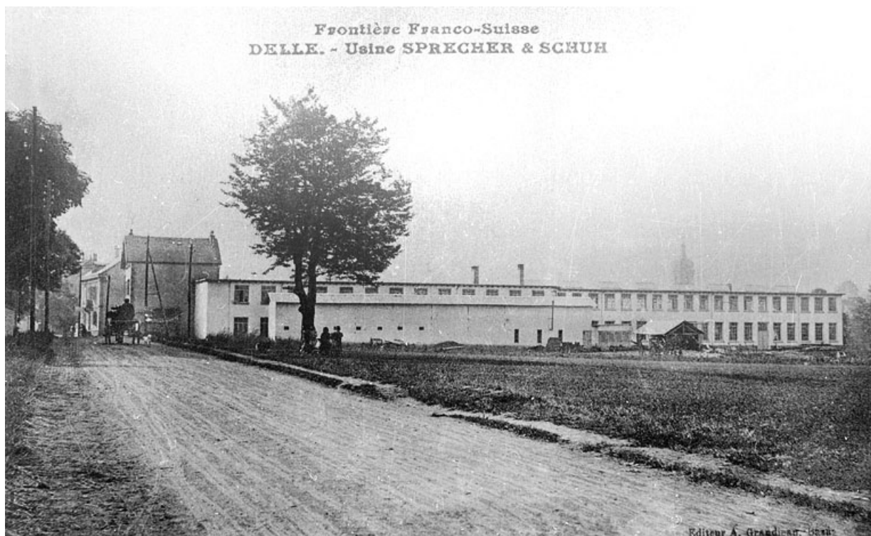
Delle. - Usine Sprecher & Schuh.
