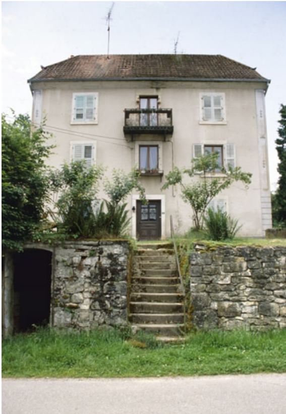
Façade antérieure du logement patronal.
